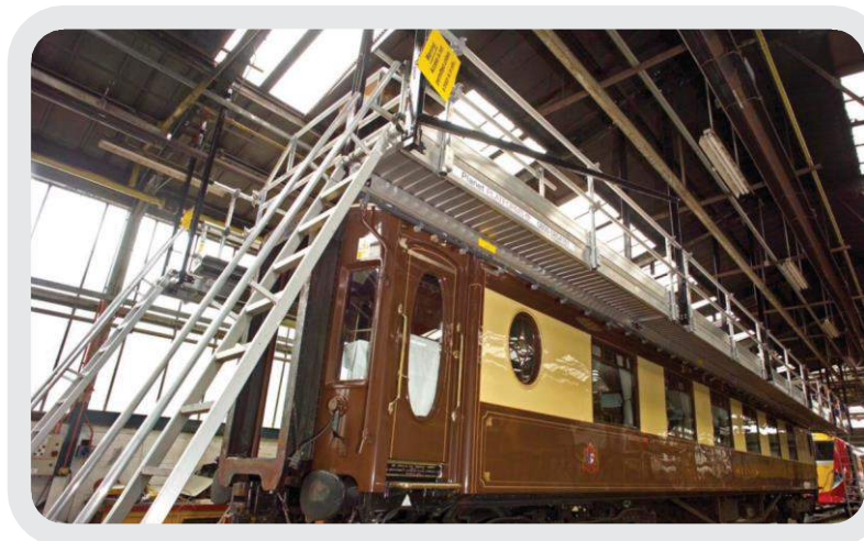
Spandek utilizada para conseguir un acceso más próximo para el mantenimiento del techo del famoso Orient Express.
