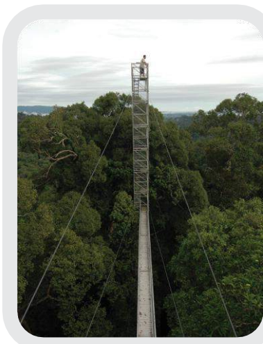
Una Spandek ancho sencillo proporciona una pasarela a la torre de observación en la selva de Brunei.
